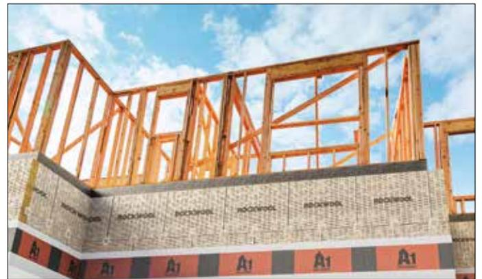
Das erste zugelassene, nicht brennbare Wärmedämm-Verbundsystem für den Holzrahmenbau erfüllt die maximalen Anforderungen an den vorbeugenden Brandschutz. (Bild: Heck Wall Systems)
