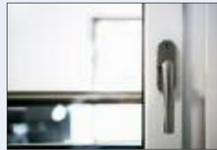
Abschließbare Fenstergriffe und mechanische Vorrichtungen wie Pilzkopfzapfen erschweren das Aufbrechen erheblich.
