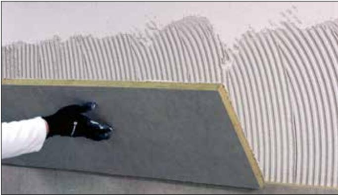
Anschließend die Dämmplatte am vorbereiteten Untergrund andrücken und einschwimmen. Es ist kein Verdübeln erforderlich. (Bild: Heck Wall Systems)
