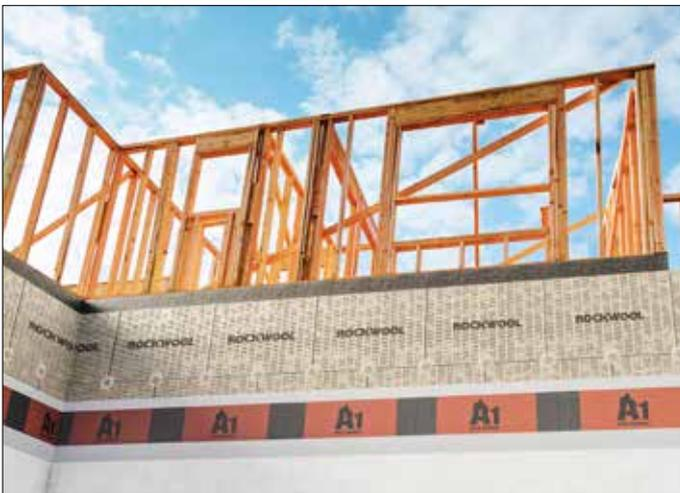
Das erste zugelassene, nicht brennbare Wärmedämm-Verbundsystem für den Holzrahmenbau erfüllt die maximalen Anforderungen an den vorbeugenden Brandschutz. (Bild: Heck Wall Systems)
